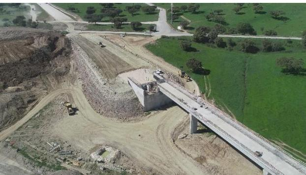
↻ Construção integral da plataforma de via-férrea, incluindo terraplenagens e sistemas de drenagem, num comprimento total de 20,5 km
